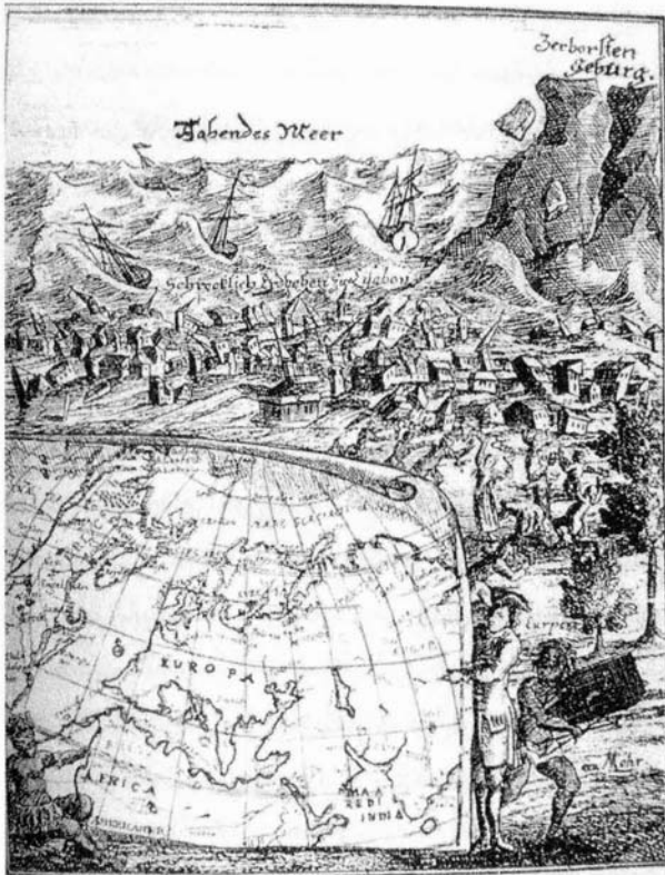
عرض لأثار زلزال وتسونامي لشبونة العام 1755. تم نشرها في 1756. الصورة مقدمة من مجموعة كوزاك، الأرشيف الإلكتروني لمؤسسة NISEE لهندسة الزلازل، جامعة كاليفورنيا، بيركلي.
